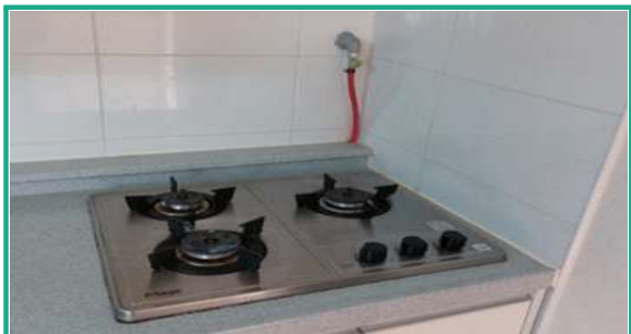
금속배관 및 퓨즈콕 설치
