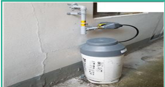
금속배관 및 용기차양 설치
