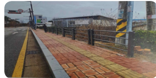
추락 위험지역에 안전펜스 설치
