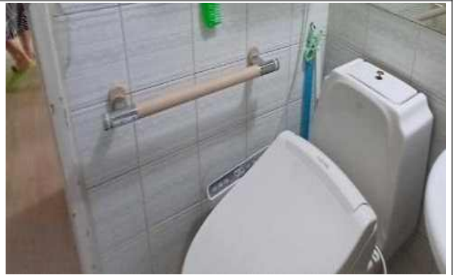
양변기 안전 손잡이 설치
