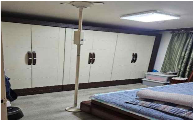
기둥형 안전 손잡이 설치
