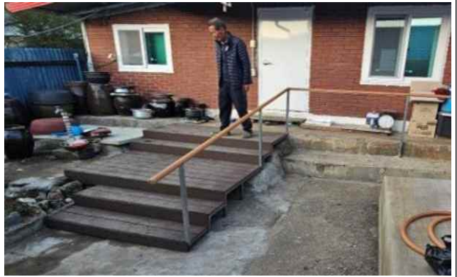
계단 및 난간 설치
