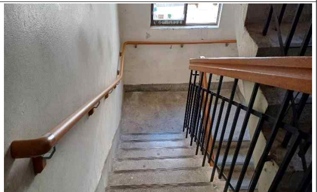
계단 핸드레일 설치
