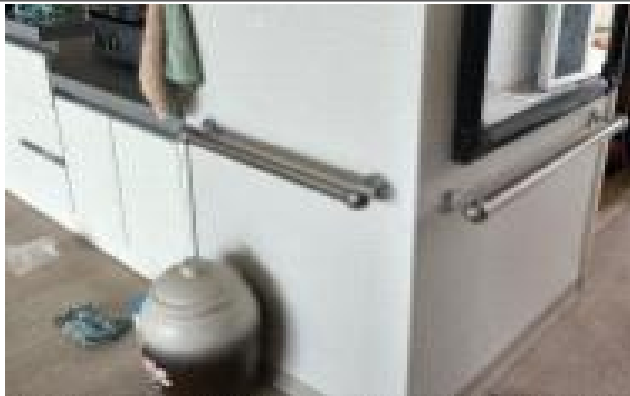
안전 손잡이 설치
