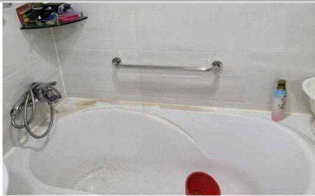
안전 손잡이 설치
