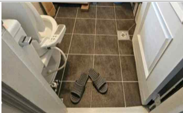
화장실 미끄럼방지 타일 설치
