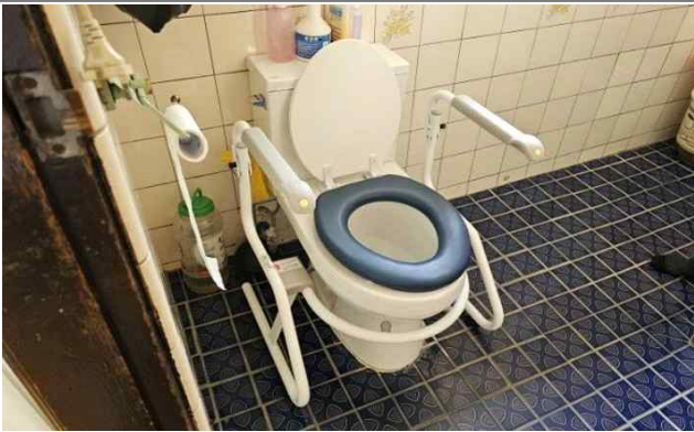
양변기 안전 손잡이 설치
